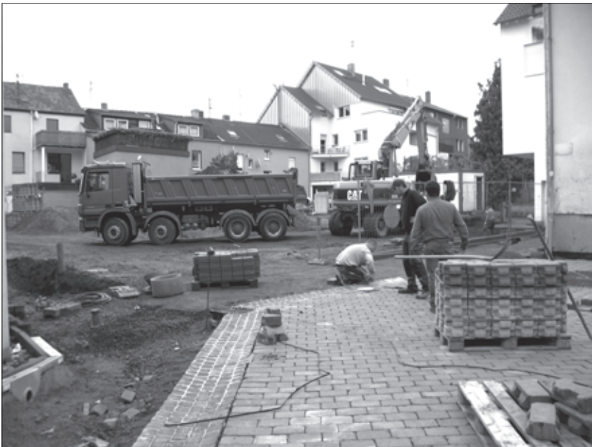
Der so genannte Blockinnenbereich zwischen Marktplatz, Marktstraße und Ismertstraße wird derzeit ausgebaut. Dem liegt ein Beschluss des Stadtrates zugrunde, der auch von der DKP-Fraktion unterstützt wurde. Bis zum Jahresende soll die Maßnahme abgeschlossen werden.
