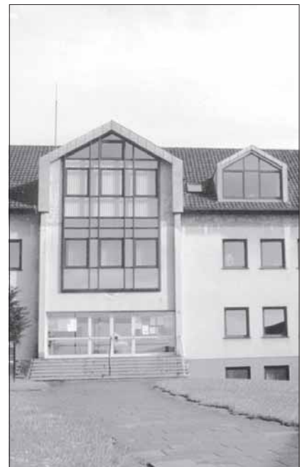
Im Kollerbacher Rathaus hat der Eigenbetrieb „Technische Dienste Stadt Püttlingen“ seinen Sitz.
